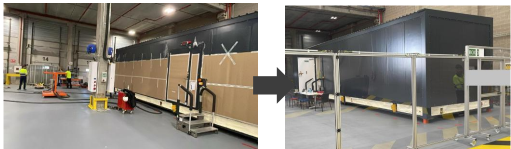
Fotografía 28: Proceso integración en curso. Fotografías hechas por autor del TFM siguiendo Anexo 0
