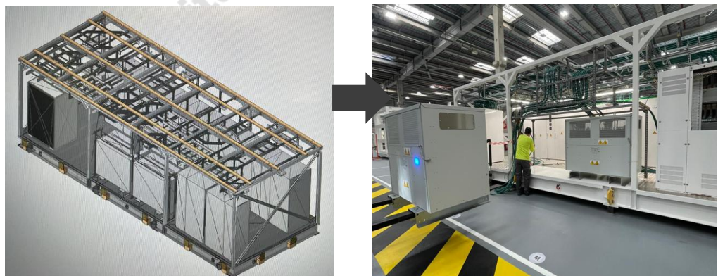
Fotografía 29: Proceso integración en curso. Fotografías hechas por autor del TFM siguiendo Anexo 0
